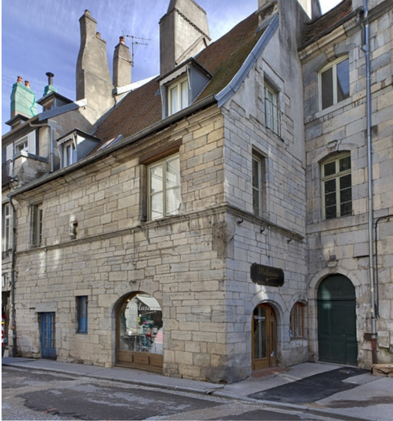
Logis principal : vue d'ensemble depuis la rue.
