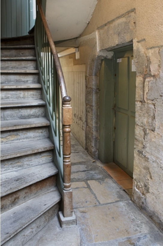
Logis principal : détail de l'escalier.
