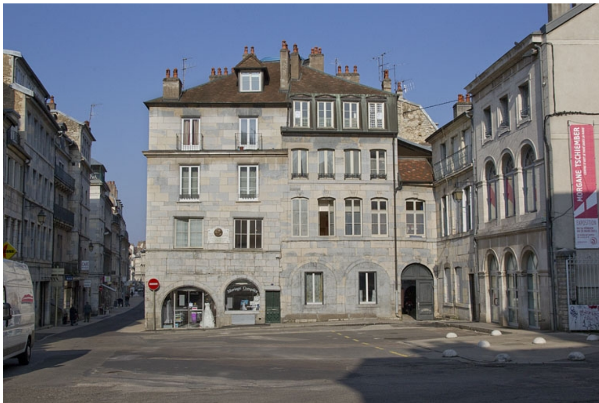
Vue d'ensemble depuis la place, de face.
