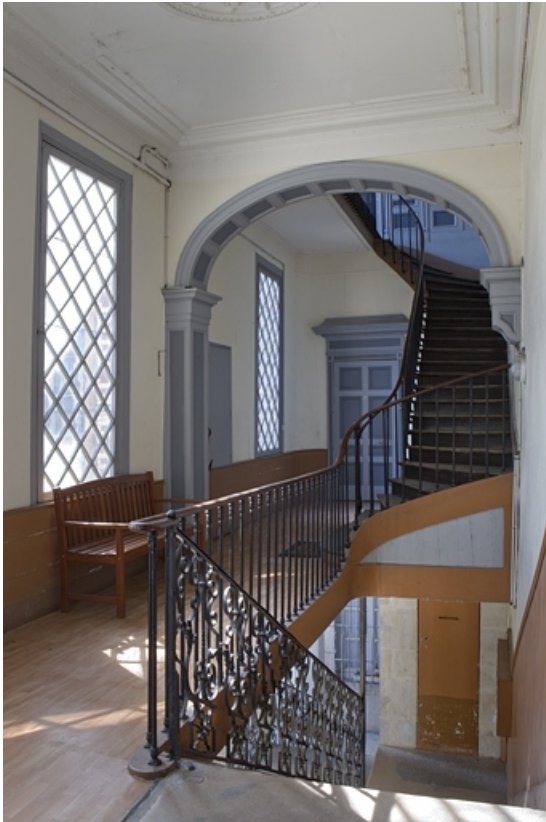
Vue des volées supérieures de l'escalier.
