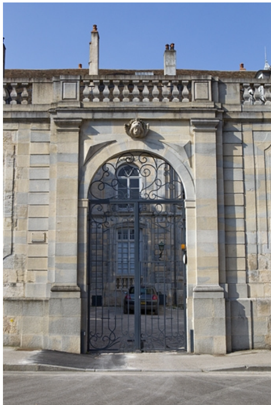
Vue d'ensemble du portail dans clôture.
