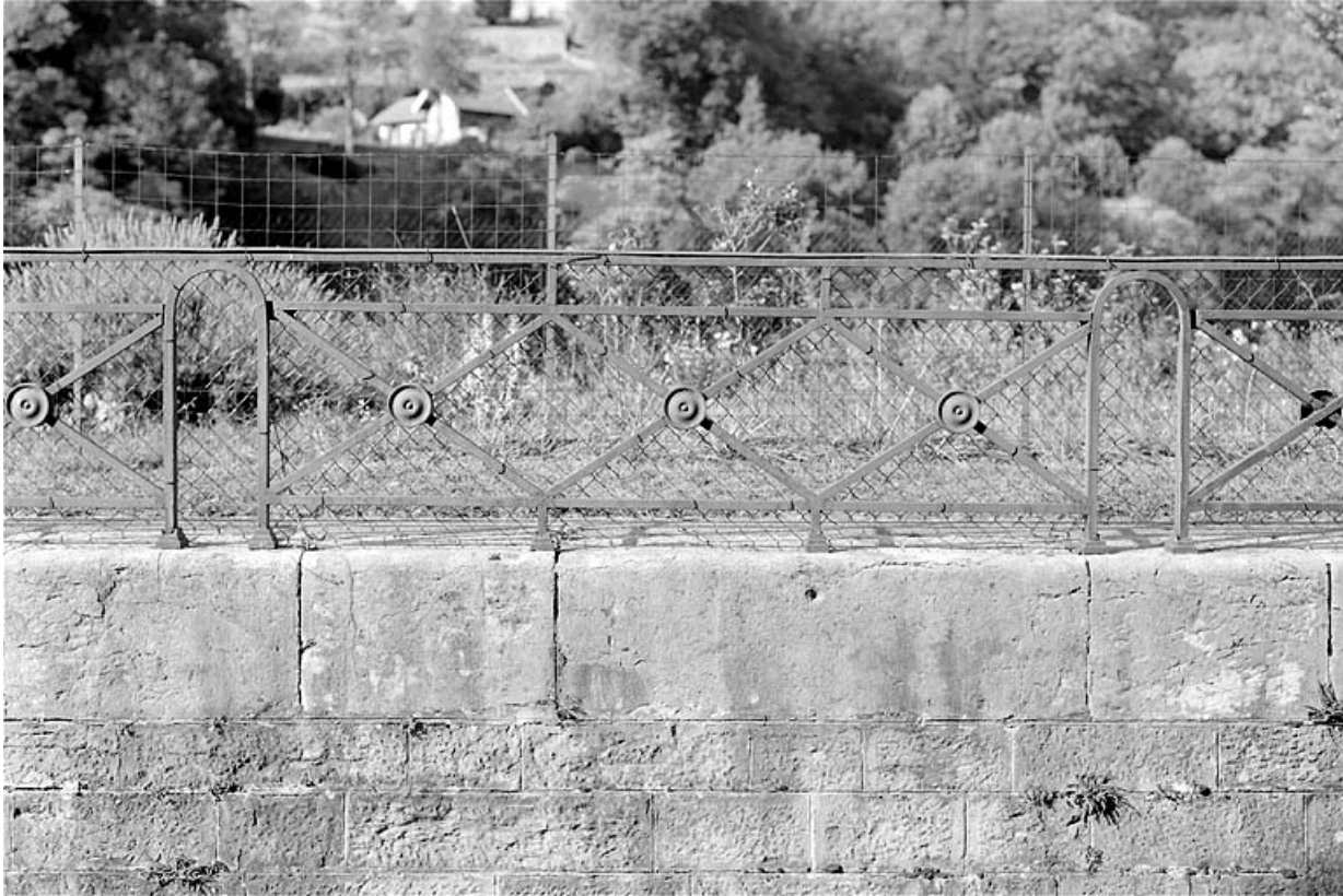
Garde-corps métallique, vu de face.
