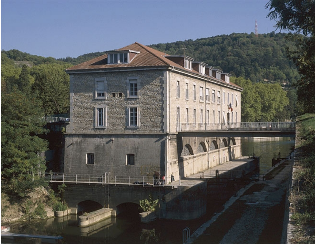
Le moulin de trois quarts gauche (aval).
