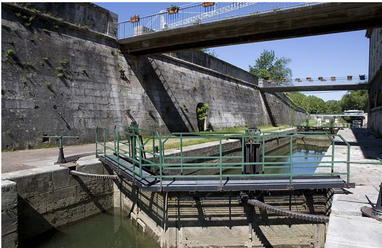
Vue d'ensemble rapprochée depuis l'amont, côté droit.
