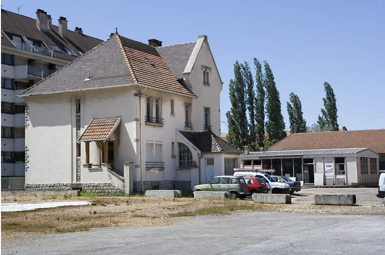
Bureau : façade postérieure de trois quarts gauche.
