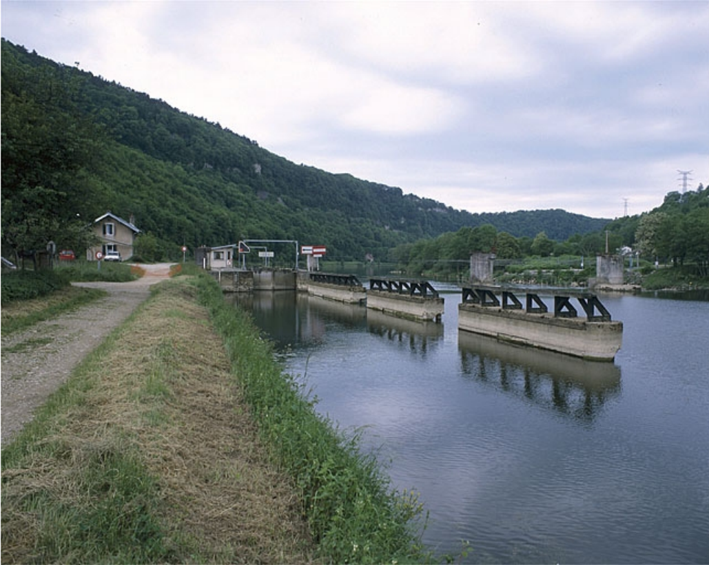
Vue d'ensemble depuis l'amont.
