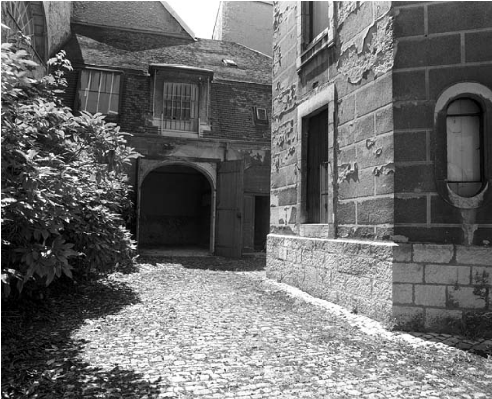
Vue du bâtiment des remises, de face.
