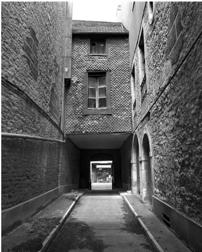
Passage cocher depuis la cour.
