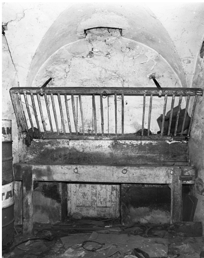
Etable : vue de l'intérieur.
