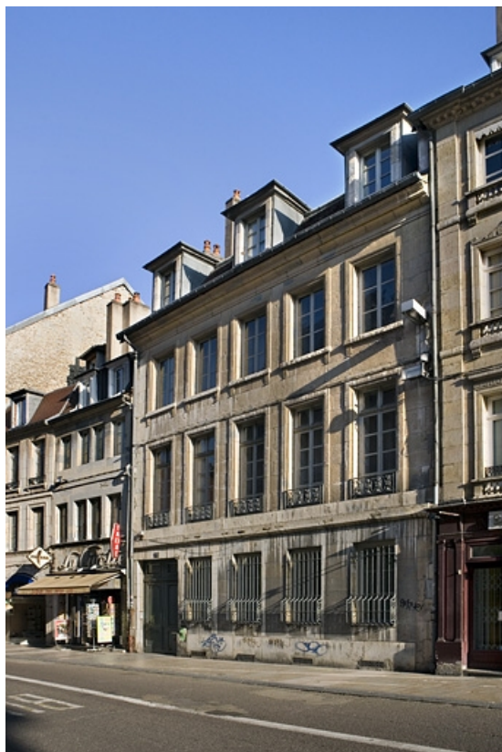
Vue d'ensemble du logis principal sur rue.
