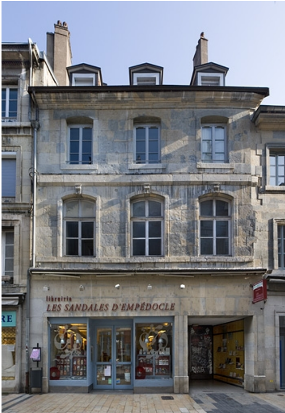
Façade sur rue : de face.
