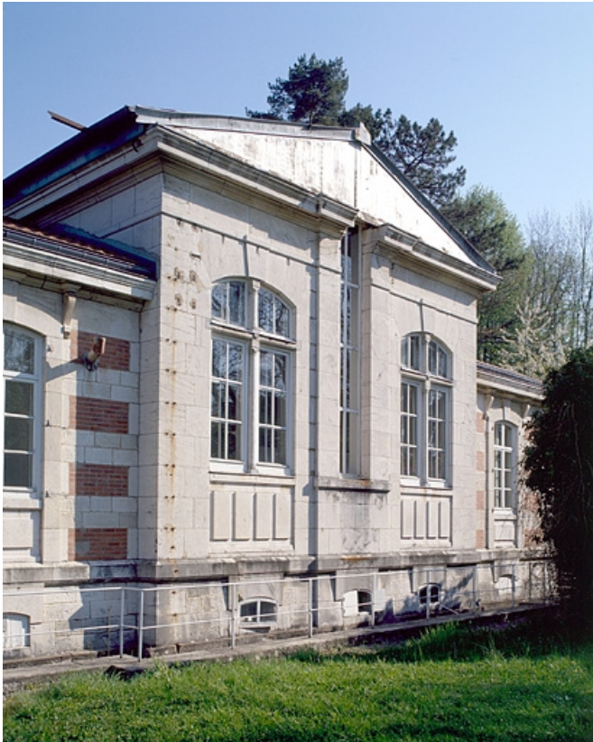
Façade sud, de trois quarts gauche.
