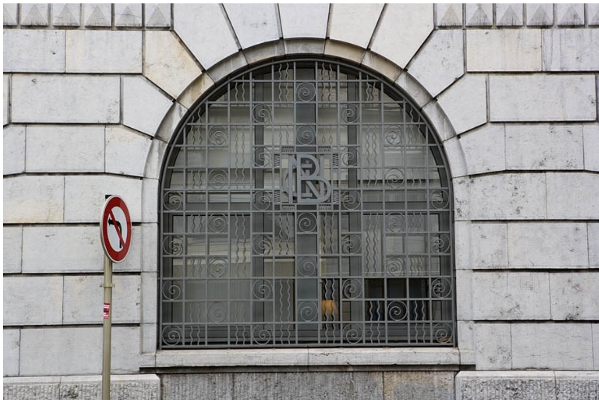
Détail d'une fenêtre du rez-de-chaussée.
