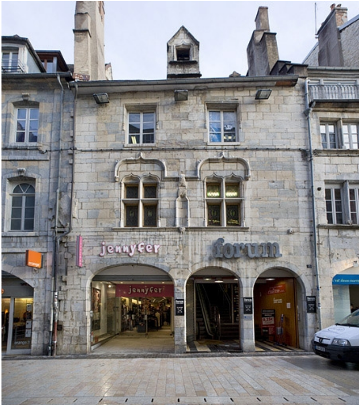
Façade antérieure du 15 Grande Rue : de face.
