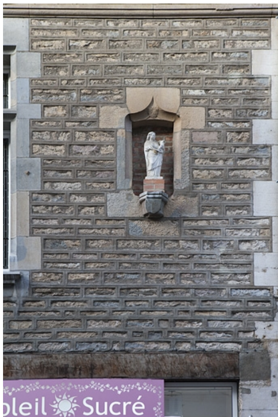
Façade rue Luc Breton : détail d'une niche.
