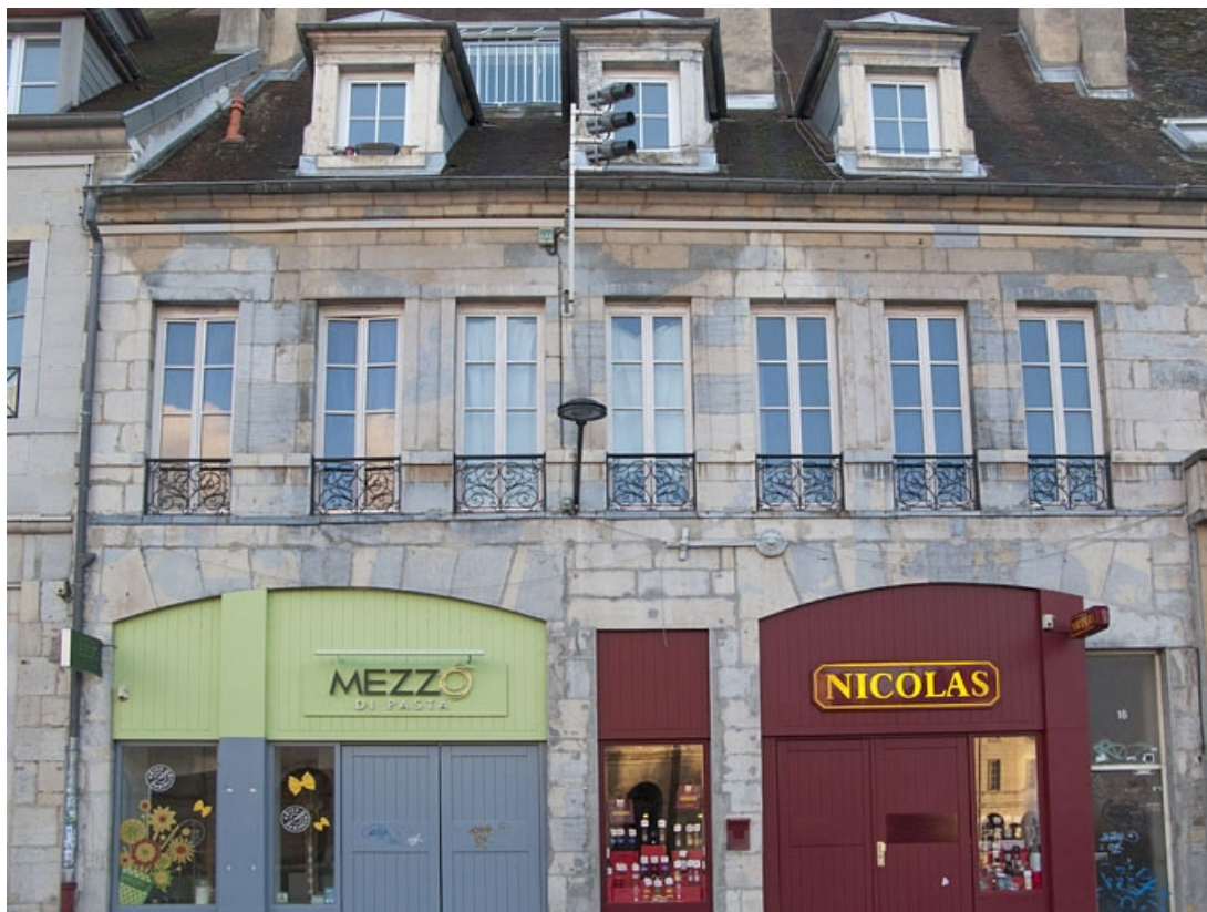
Vue d'ensemble rapprochée de la façade antérieure.
