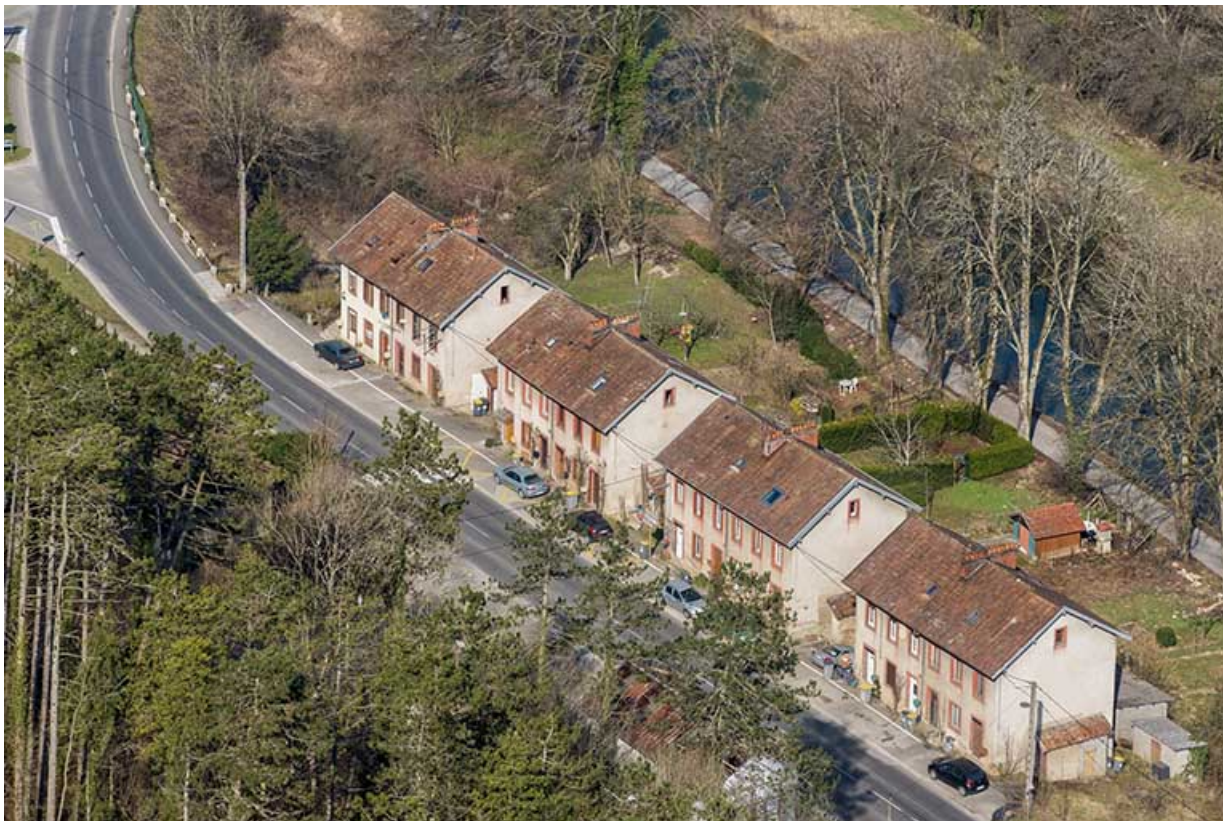
Vue plongeante depuis le sud-est.
