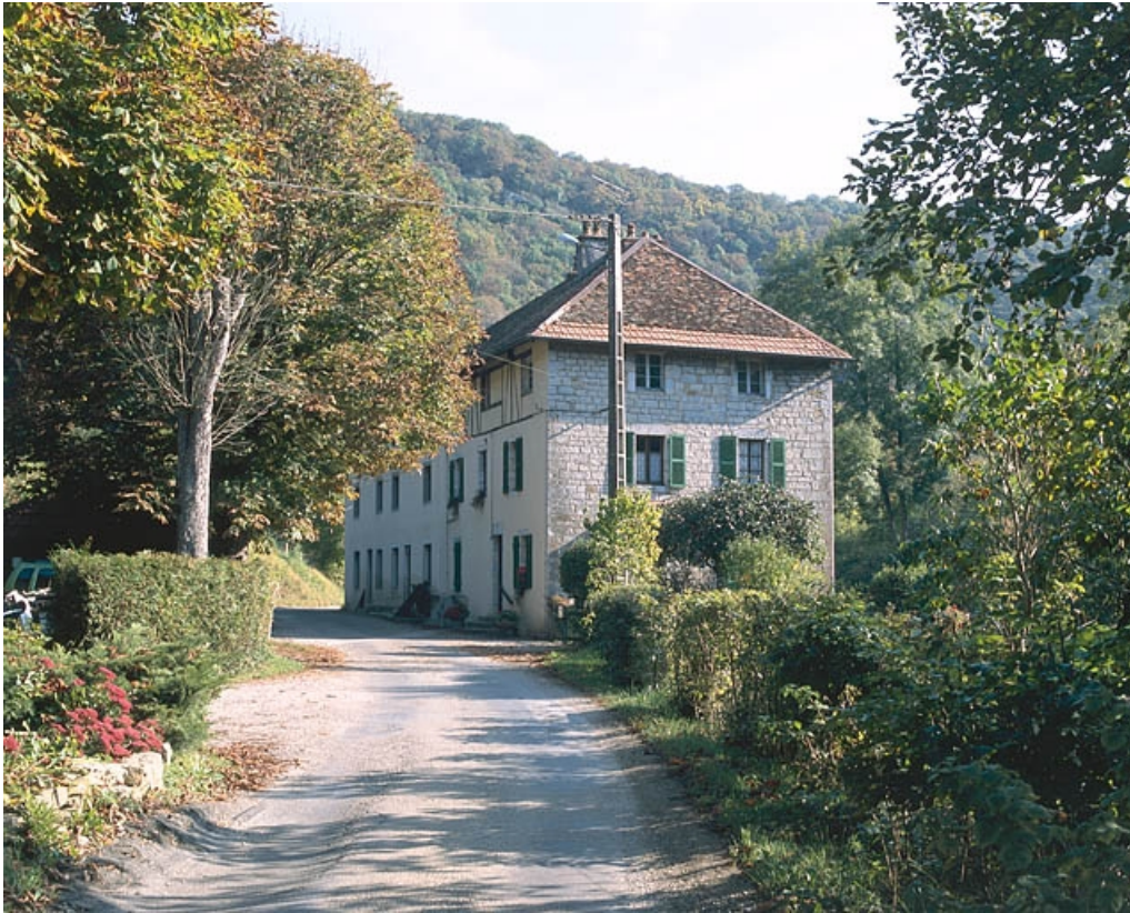
Vue depuis l'ouest.
