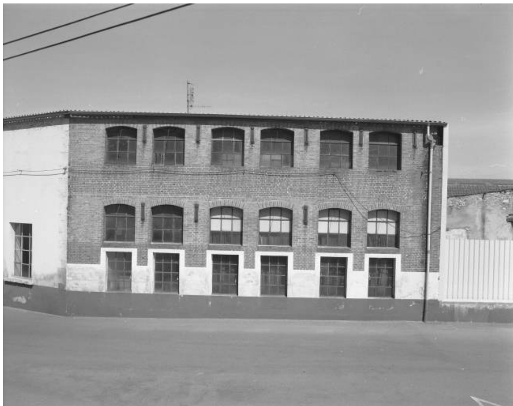
Atelier de contrôle. Vue de face.
