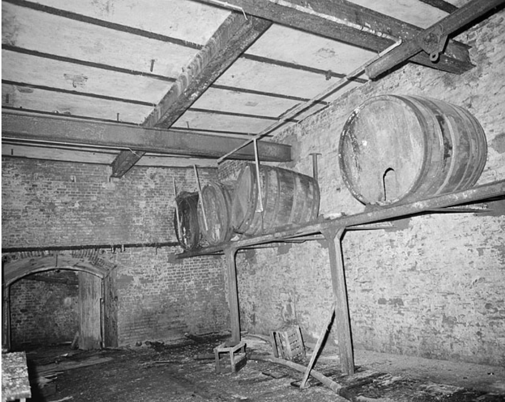
Rez-de-chaussée, salle des tonneaux.
