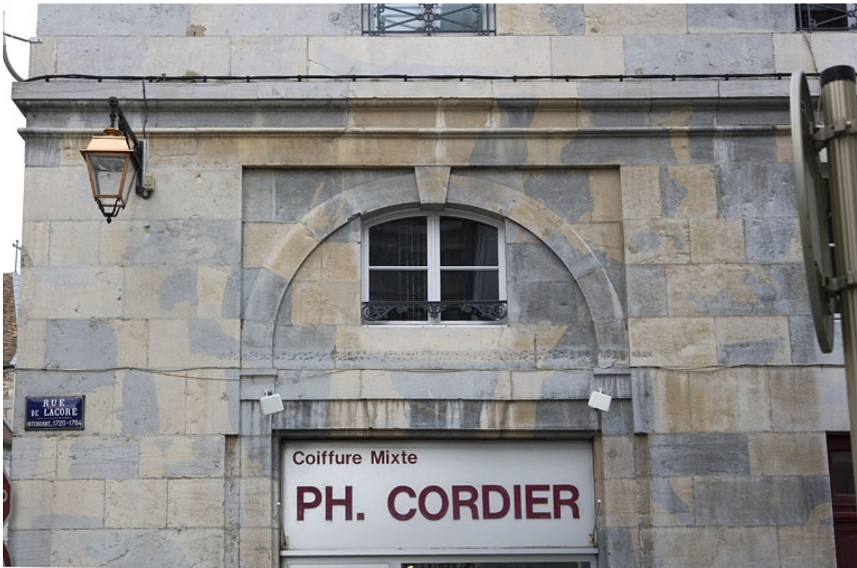
Détail d'une baie sur la rue secondaire.
