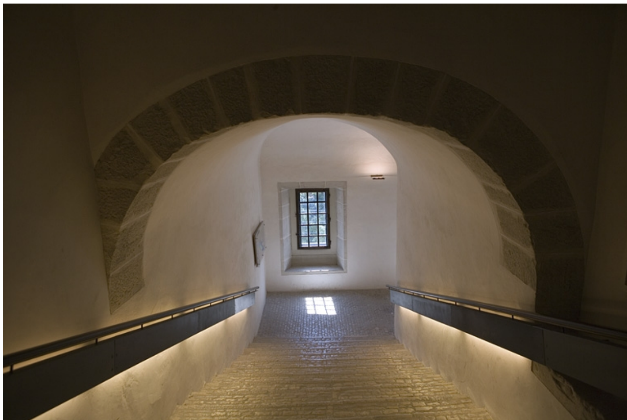
Escalier : quatrième volée depuis le haut.
