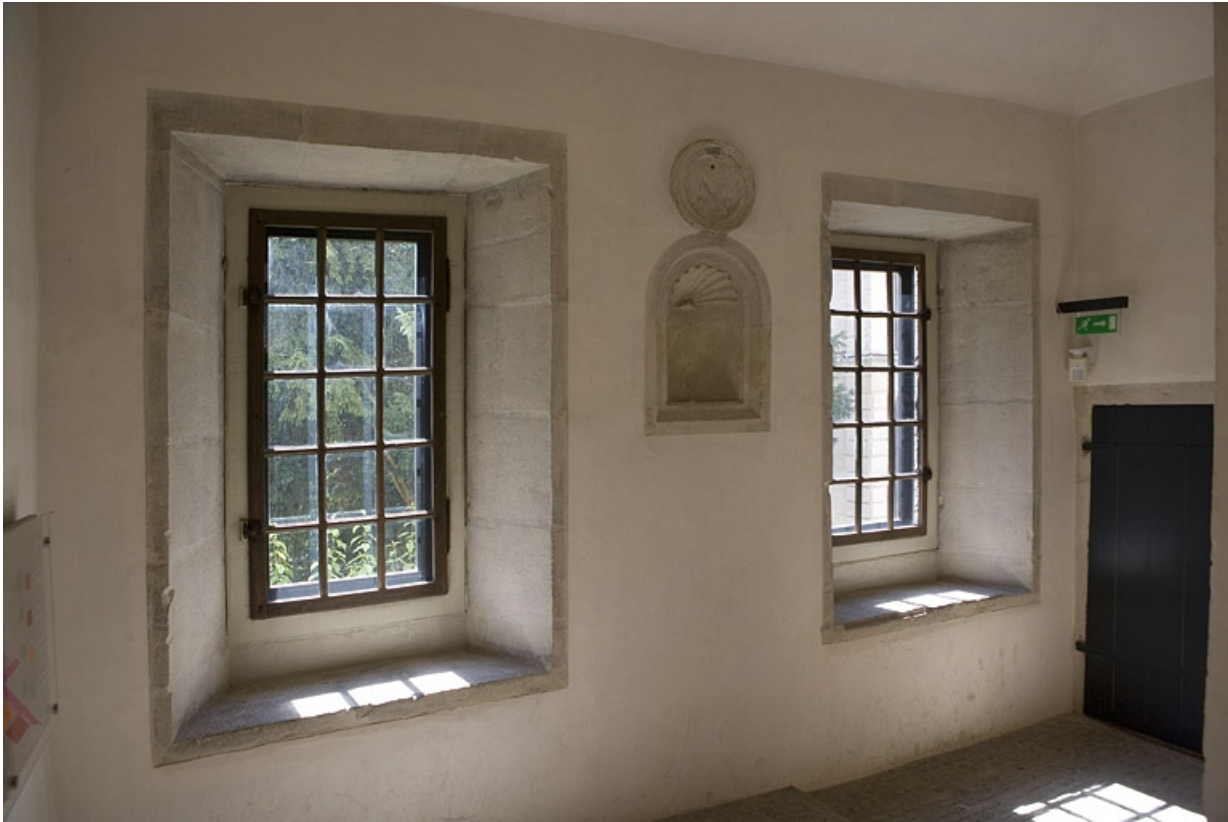
Escalier : fenêtres et niche du premier palier.
