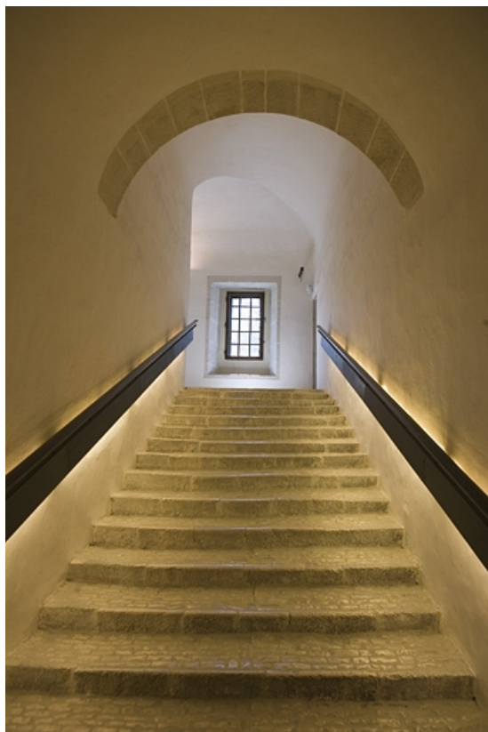
Escalier : troisième volée.
