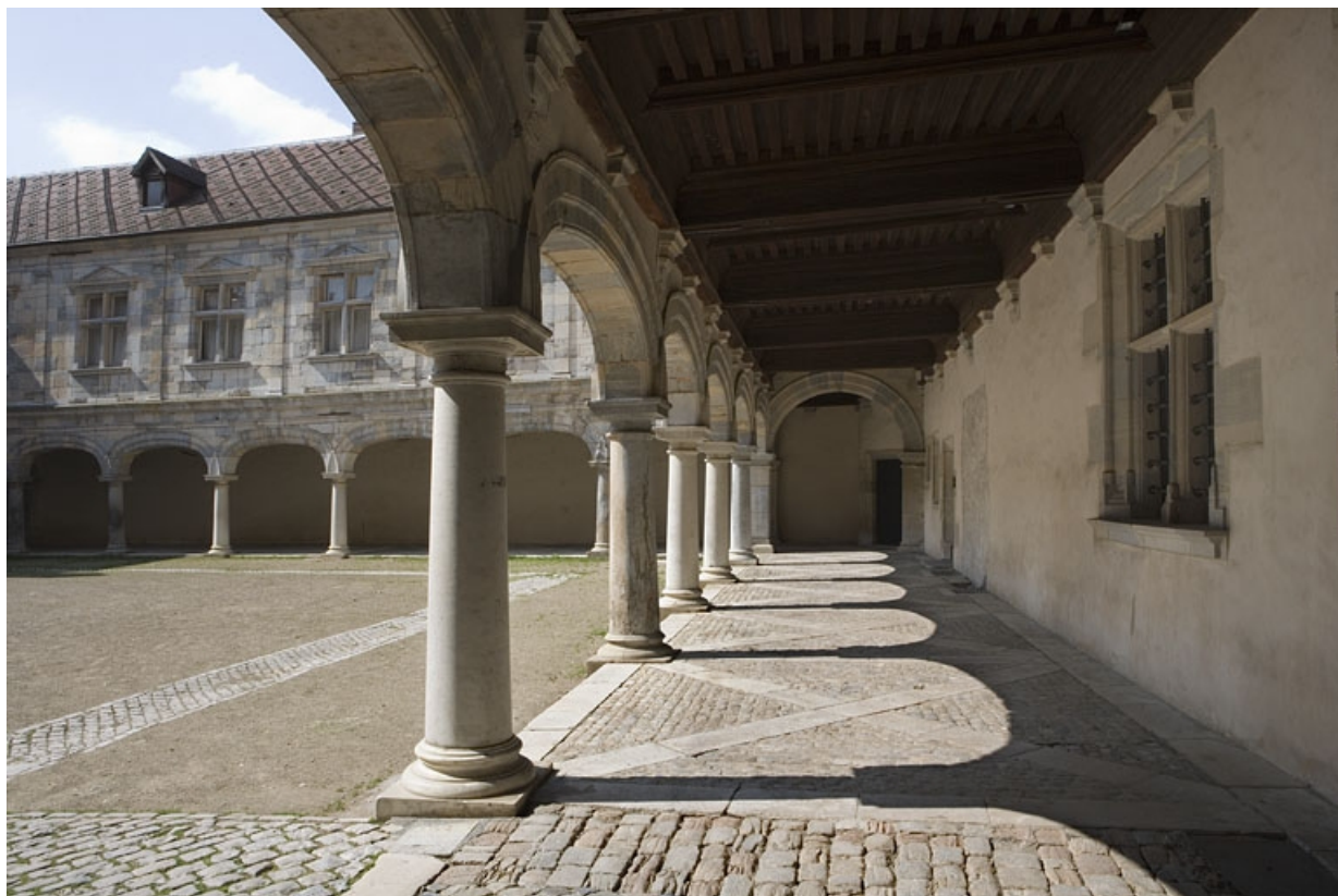
Vue d'ensemble de la galerie nord-est.
