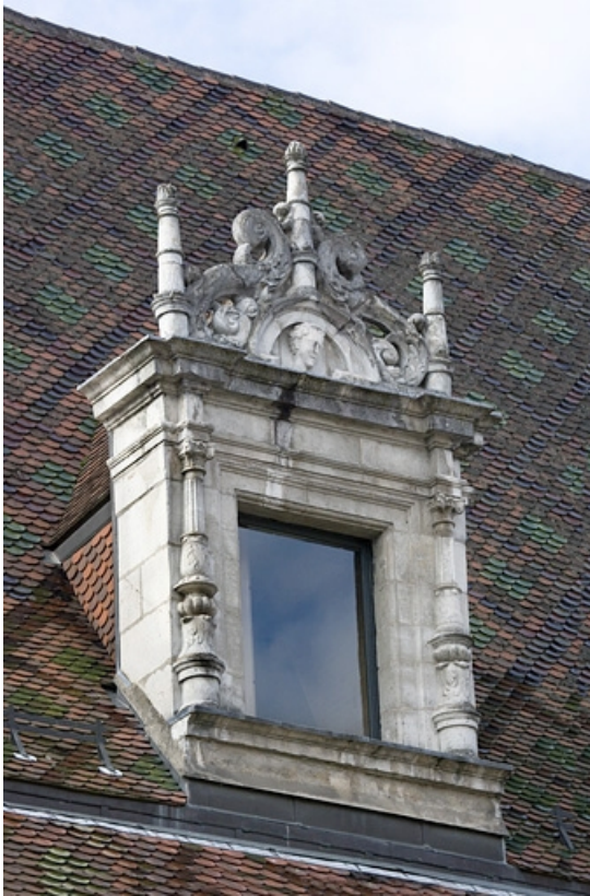
Détail d'une lucarne.
