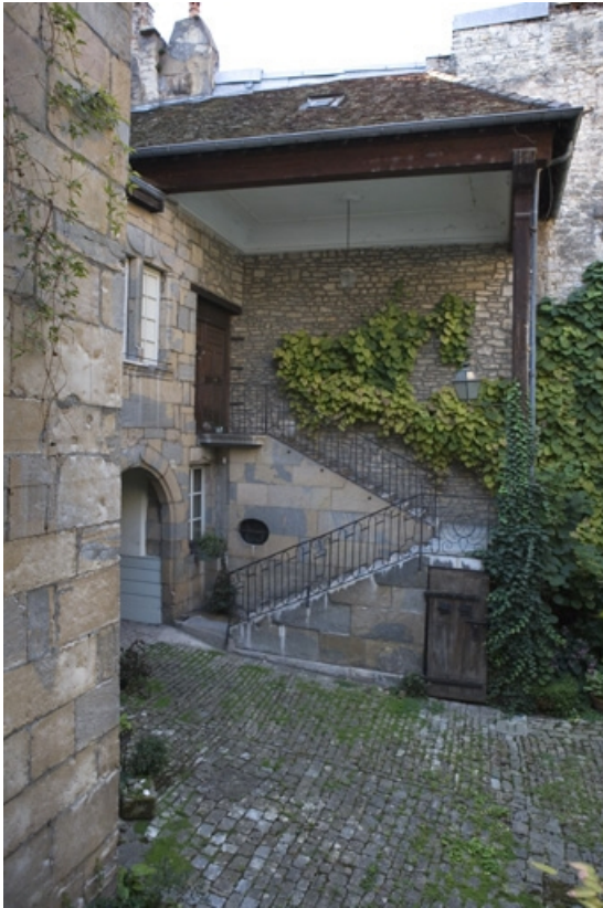
Vue d'ensemble de l'escalier extérieur, de face.
