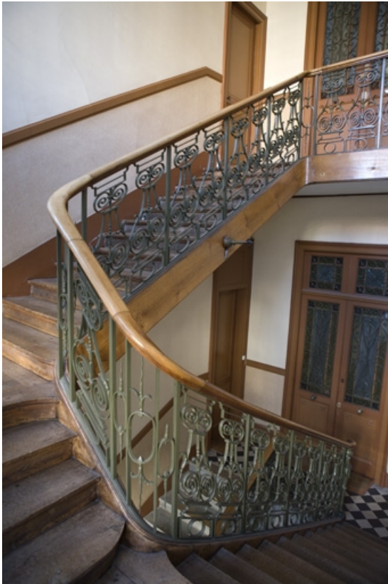
Vue d'ensemble de l'escalier principal.
