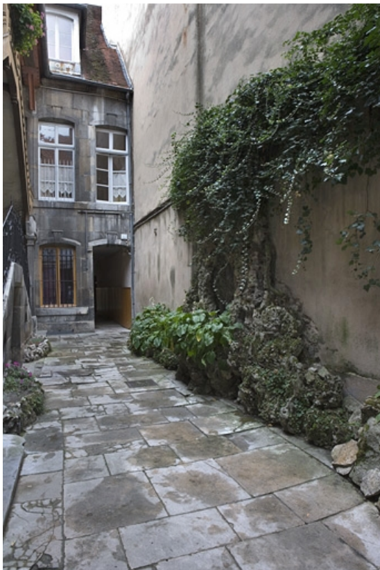
Façade antérieure du logis secondaire sur cour.
