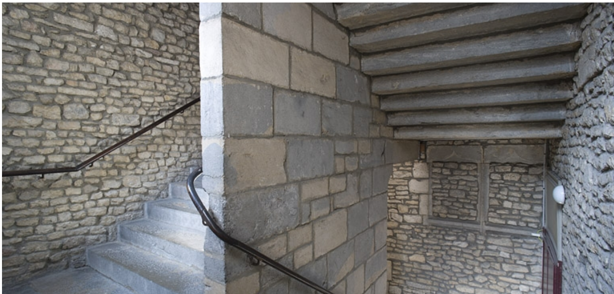
Détail de l'escalier principal en maçonnerie.
