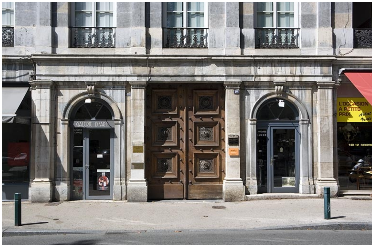
Façade sur rue : détail du portail d'entrée.
