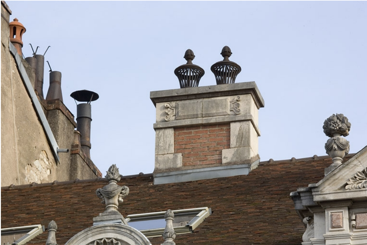
Détail d'une souche de cheminée.
