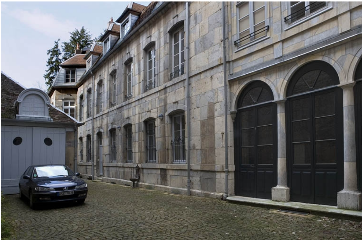
Vue d'ensemble de l' aile sur cour.
