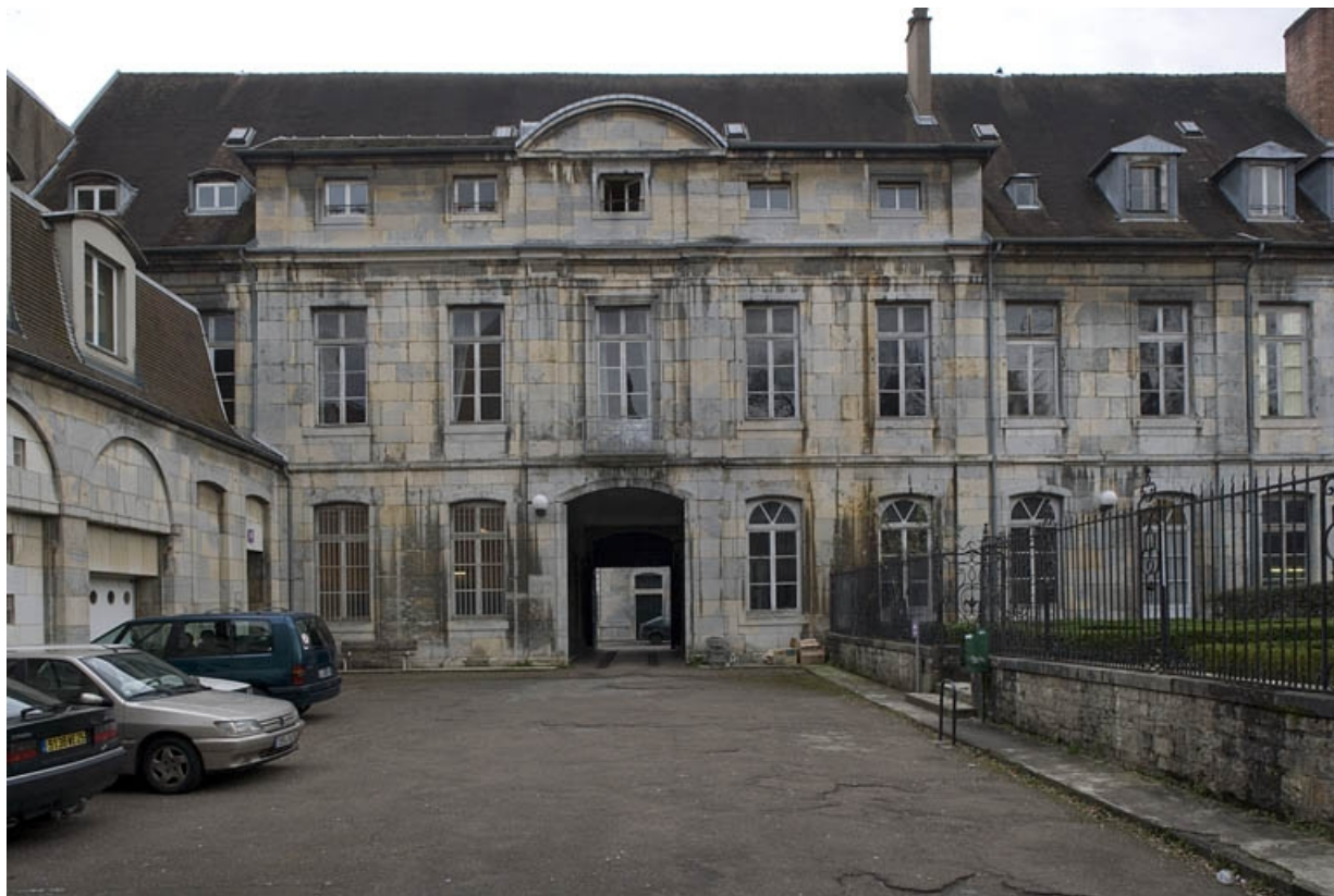
Vue de la façade sur cour.
