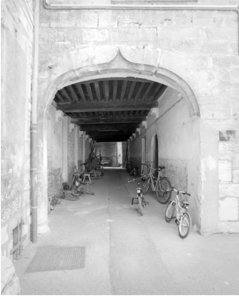
Passage dans la deuxième cour : vue d'ensemble.
