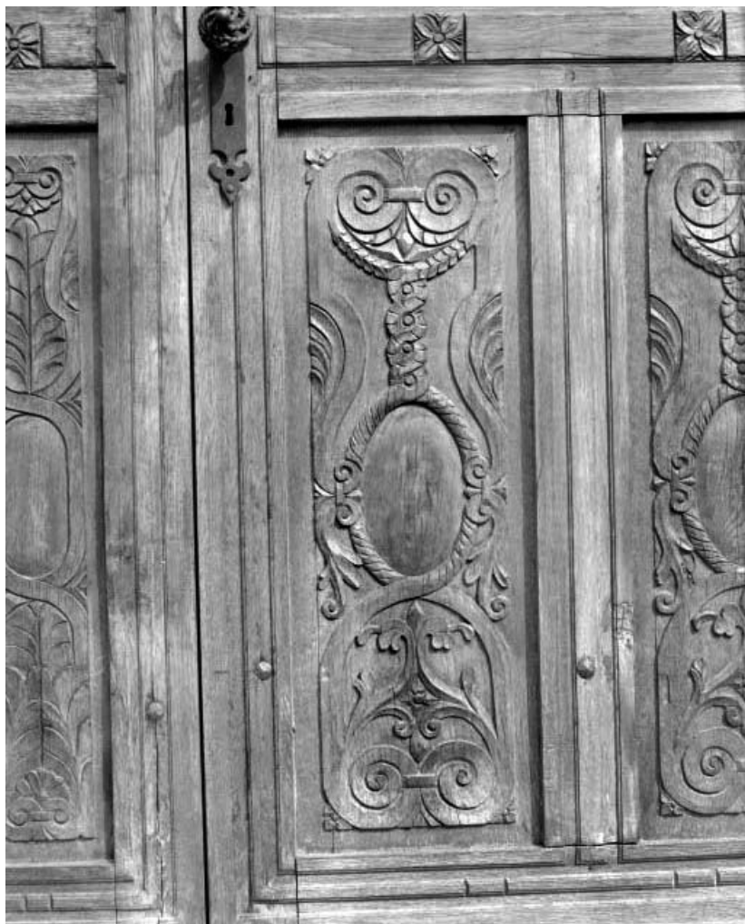
Détail de la porte du logis.
