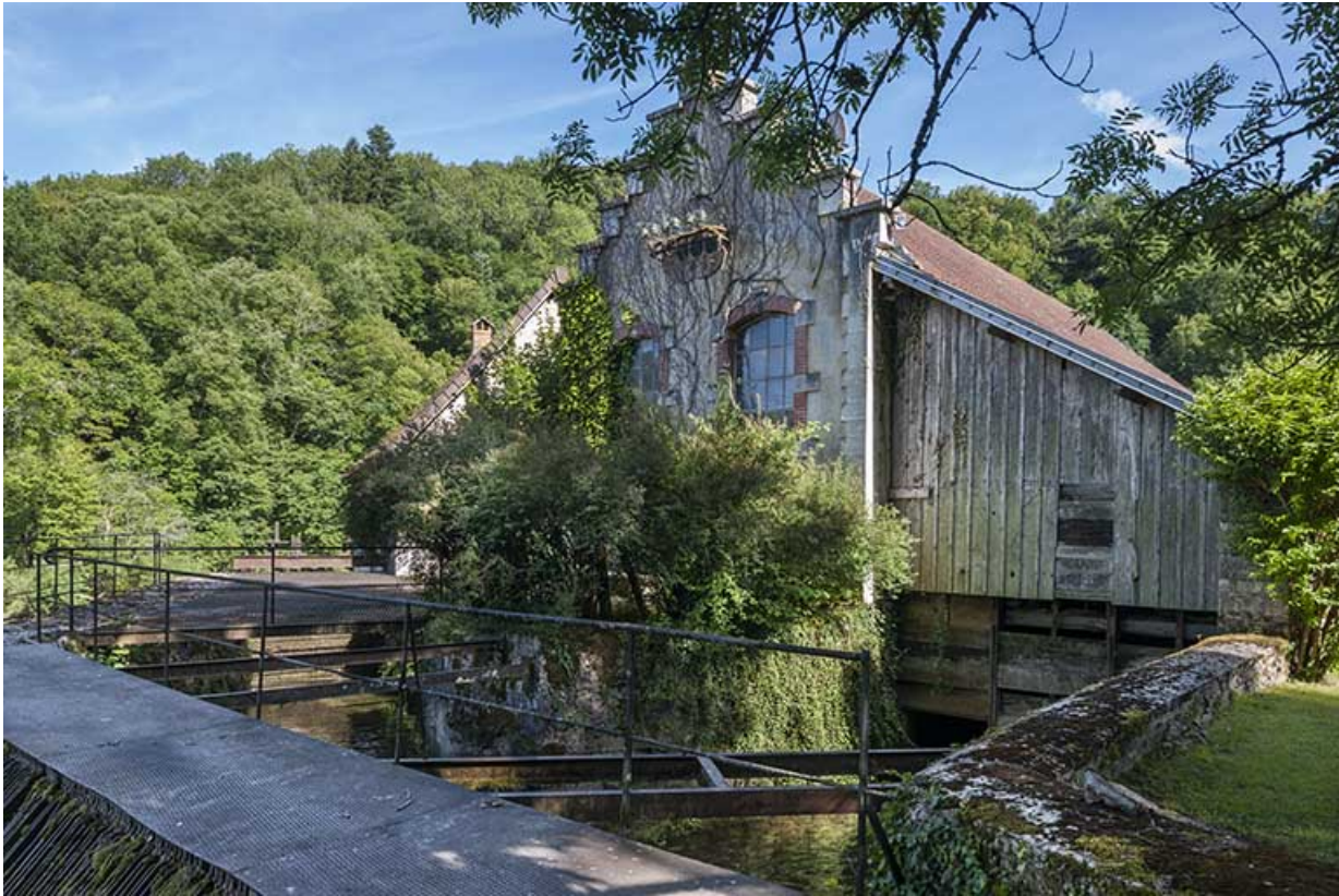
Prise d'eau, centrale hydroélectrique et bâtiment d'eau.
