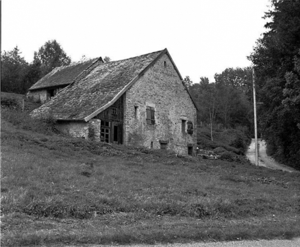
Vue générale de trois quarts gauche. 25, Scey-Maisières
