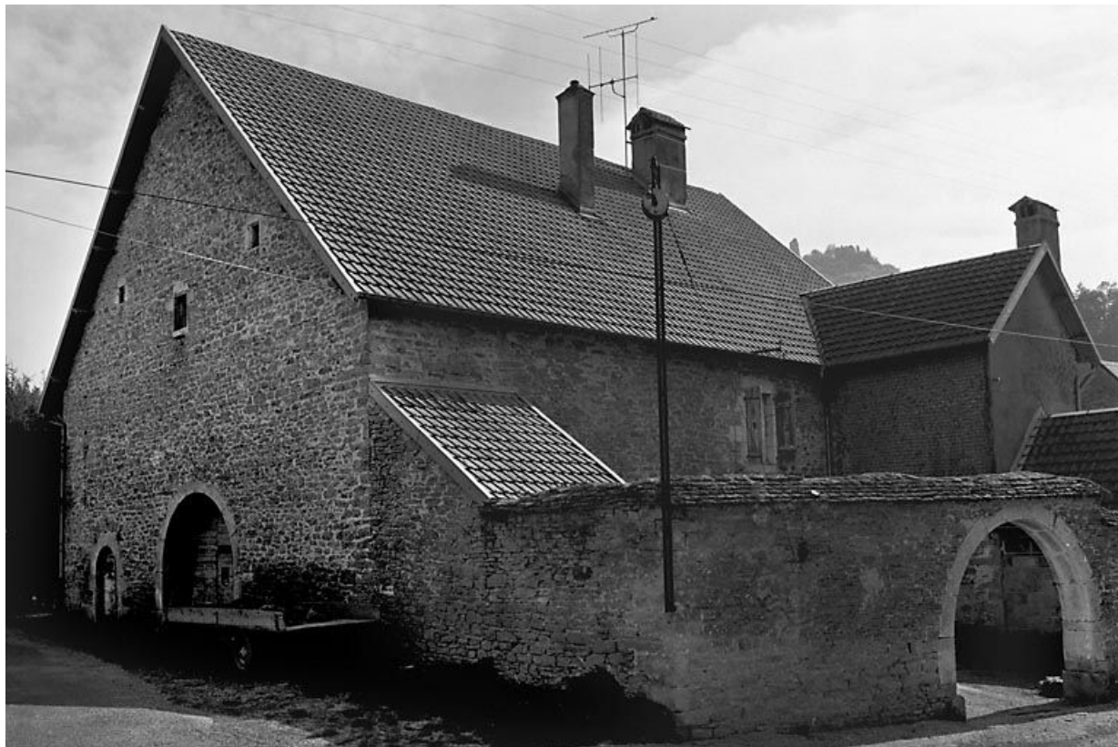
Façade antérieure et face latérale gauche. 25, Scey-Maisières
