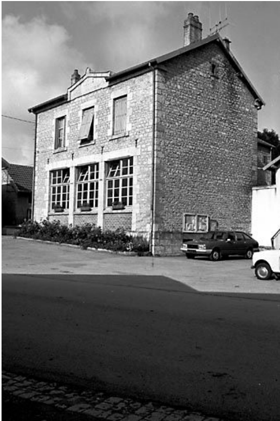
Façade postérieure et face latérale gauche. 25, L'Hôpital-du-Grosbois
