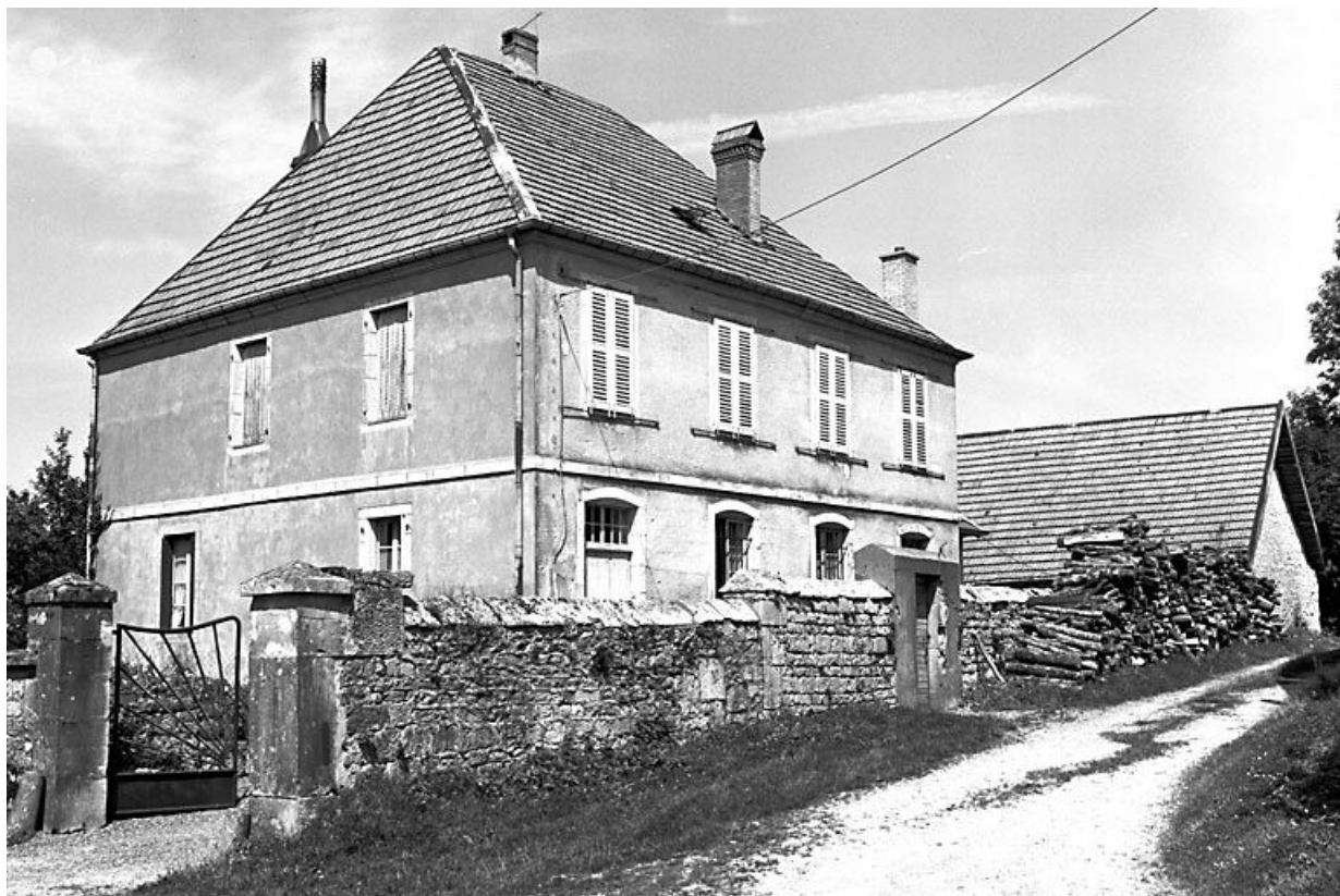
Façade antérieure et face latérale gauche. 25, Foucherans
