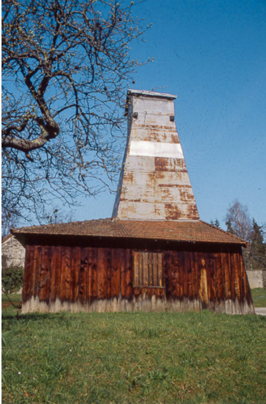
Puits de sondage nord : vue de côté.
