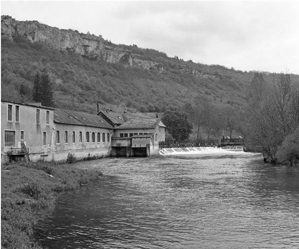
Vue d'ensemble depuis l'ouest en 1977.
