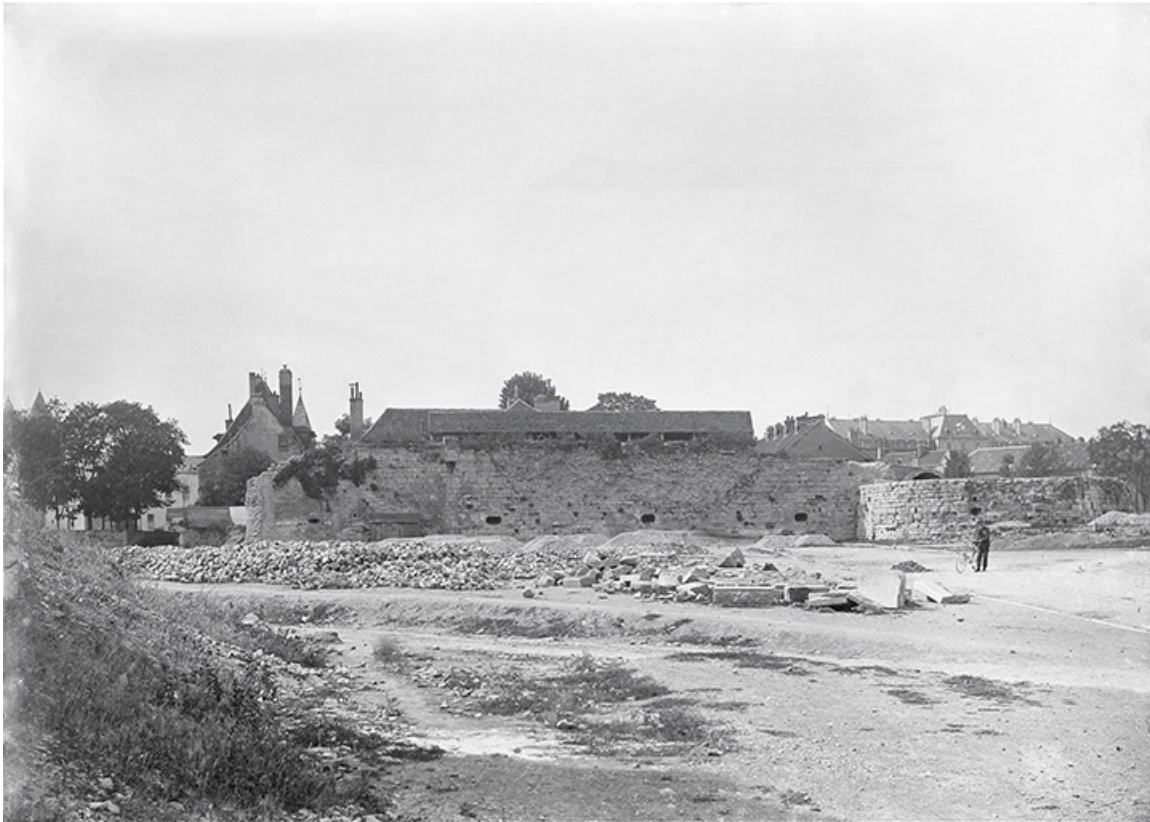
Démolition du château. [1890-1897].
