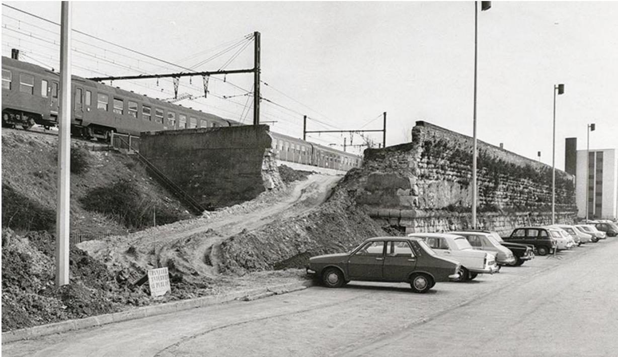
Bastion de Guise. 1971. 21, Dijon rue des Corroyeurs
