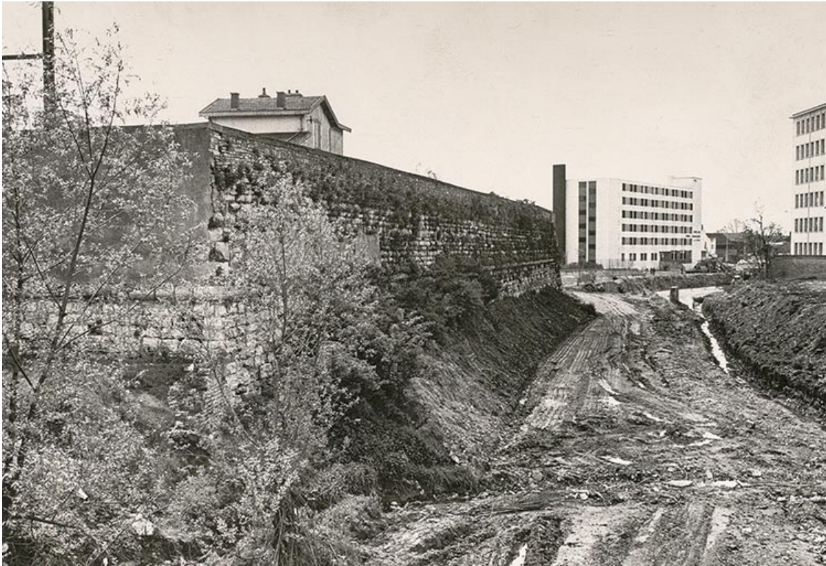
Fortifications du Bastion de Guise. 1969.
