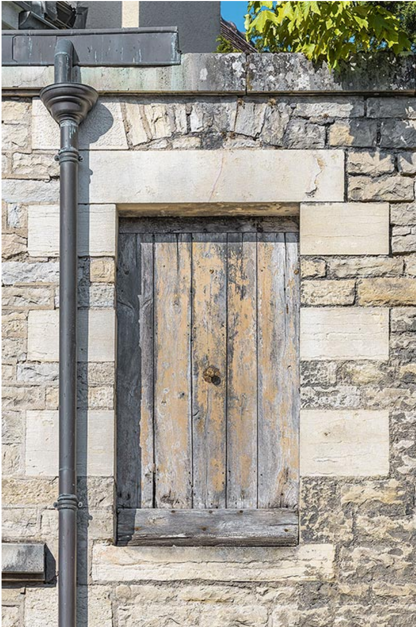
Détail d'une des portes, rue Diderot.
