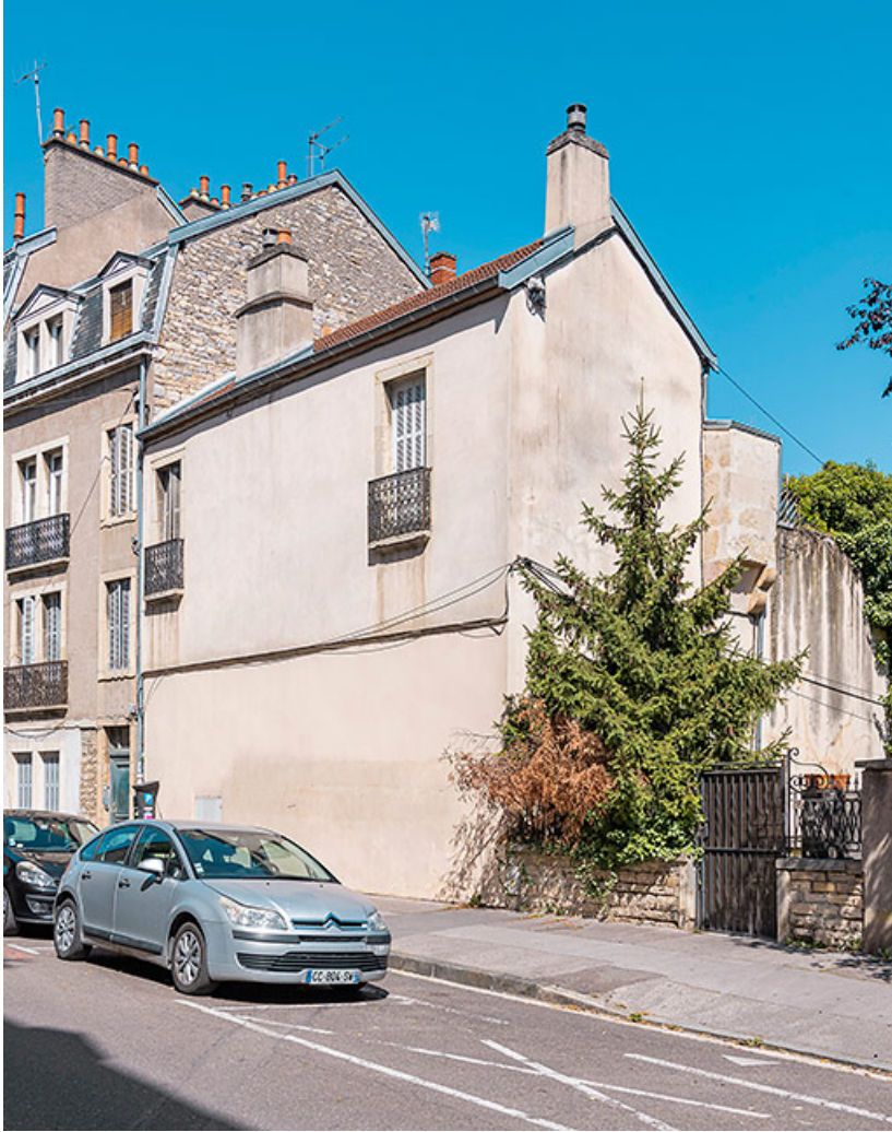
Bâtiment conservant une bretèche, rue Berlier. 21, Dijon
