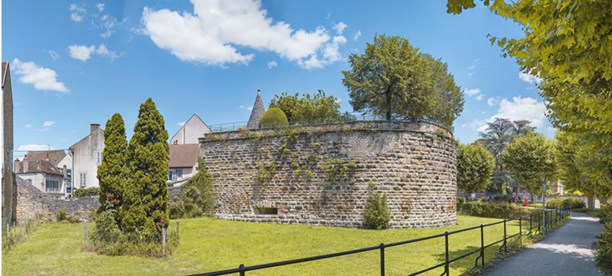
Vue générale depuis le boulevard Perpreuil.
