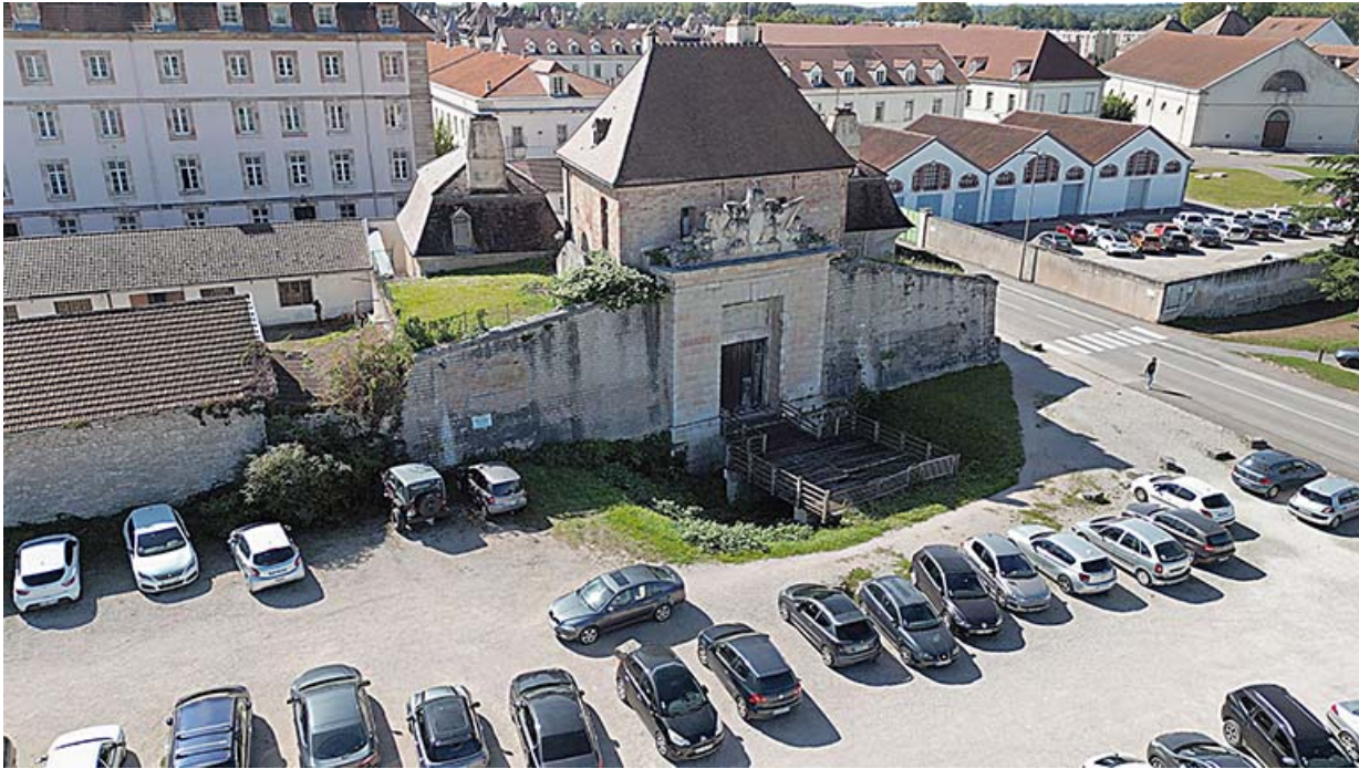
Vue aérienne de la porte.
