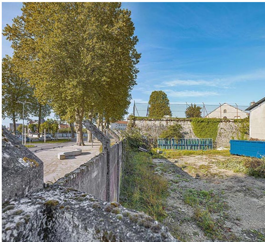
La face est du bastion.
