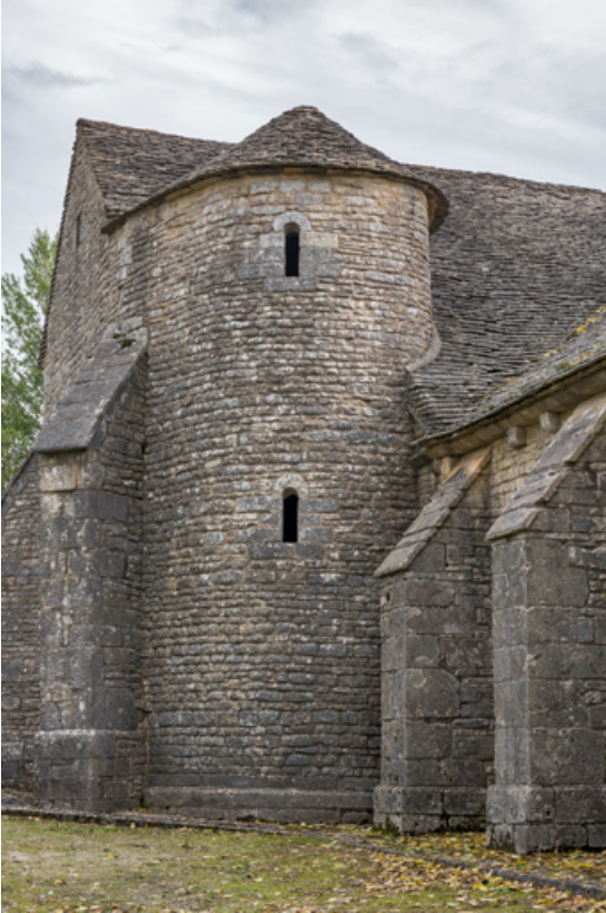
Tourelle d'escalier côté nord.
