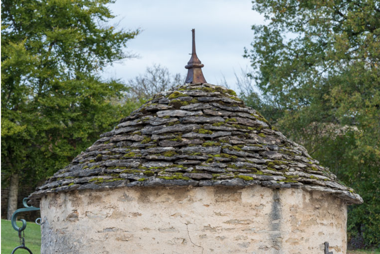
Détail de la toiture.
