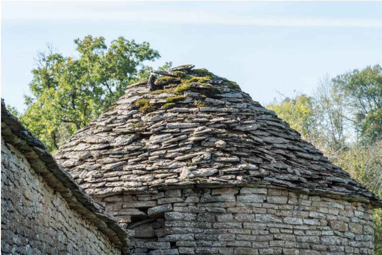
Détail de la toiture tour sud.
