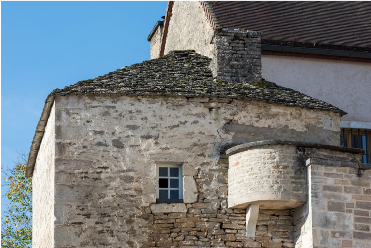
Vue de la toiture depuis l'ouest.
