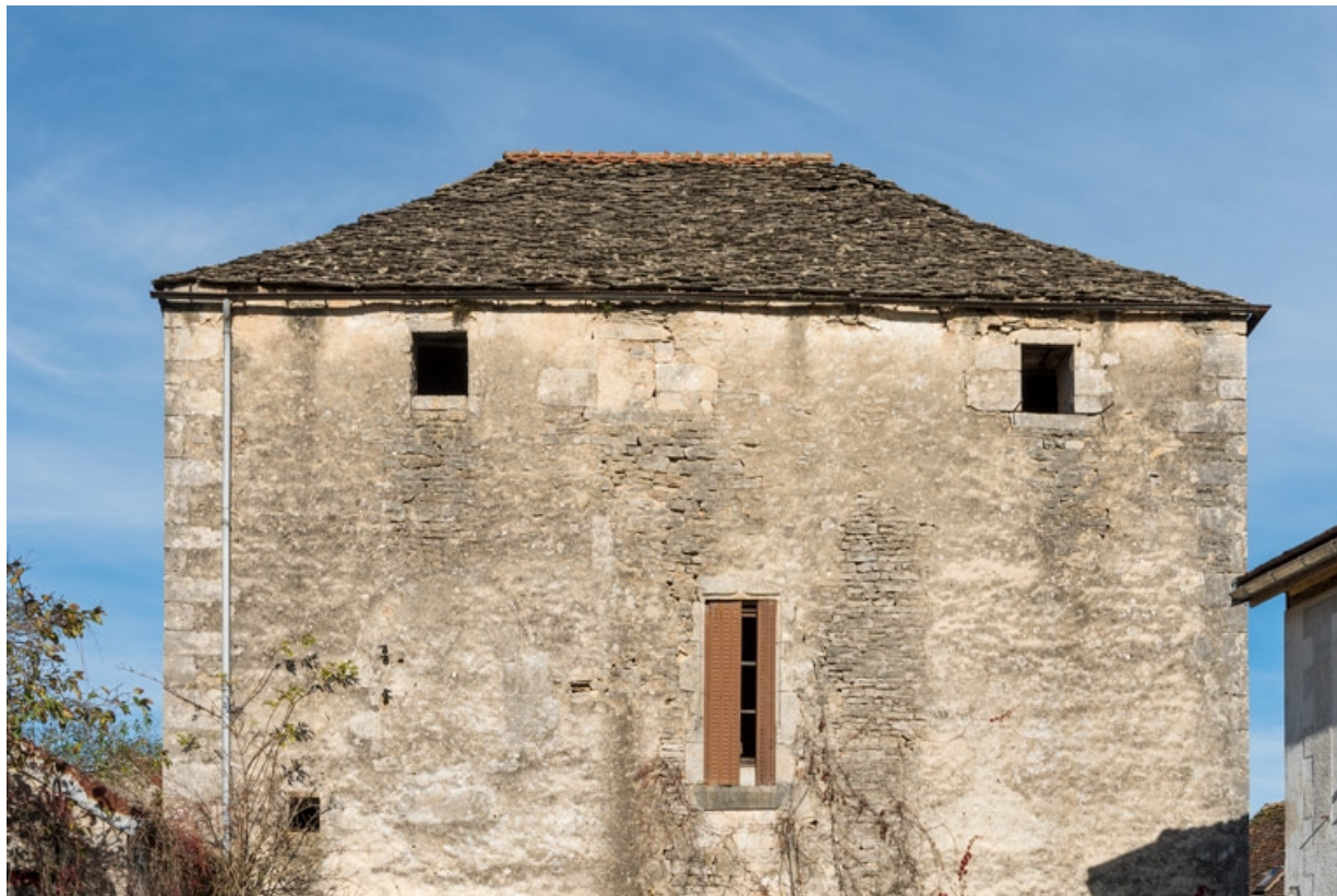
Détail de la toiture côté sud.
